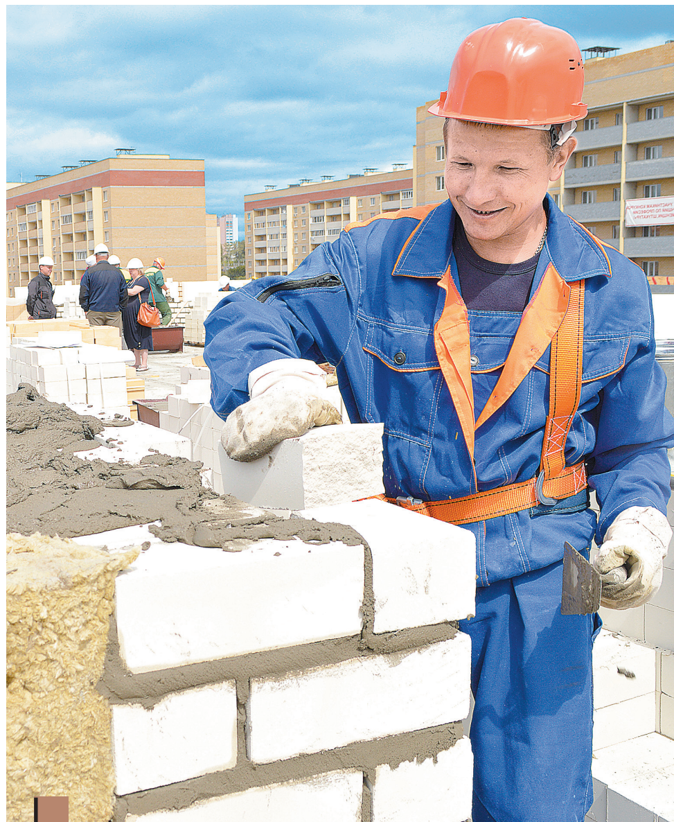
Строители привыкли быть на высоте.
