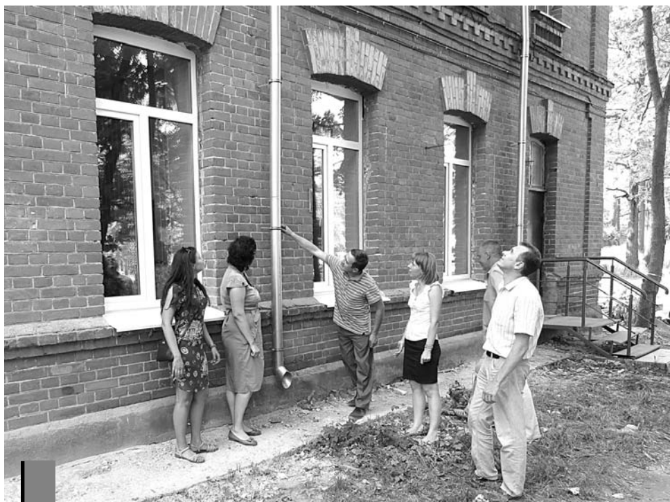
Военный городок. Приемка дома после ремонта проходит с участием жильцов.
