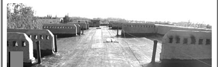
ПОСЛЕ КАПРЕМОНТА: Кузнецк, ул. Молодой Гвардии, 125.
