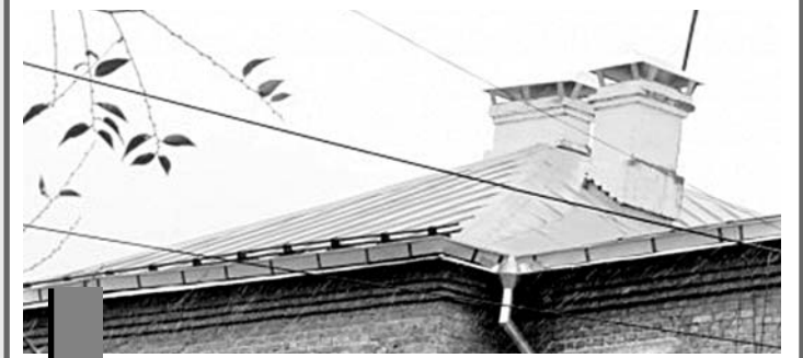
ПОСЛЕ КАПРЕМОНТА: Пенза, ул. Володарского, 38–40.
