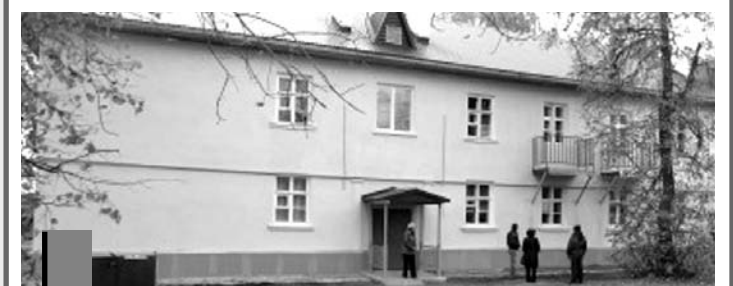
ПОСЛЕ КАПРЕМОНТА: Каменка, ул. Рокоссовского, 43.
