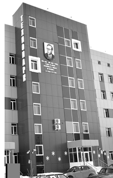
В «Рамееве» сосредотачивается самое передовое оборудование. Фото Владимира Гришина.
