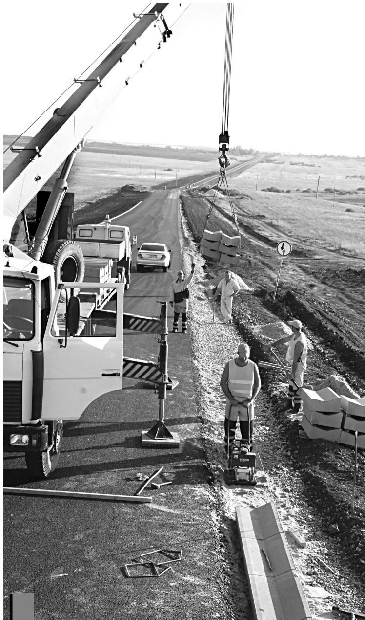
В 2015 году отремонтировано 280 км областных дорог.
